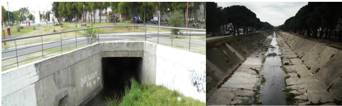
Figuras 1.2.4.2. Comienzo del entubado del Arroyo Naposta (izq.) y Canal Maldonado (der.)
